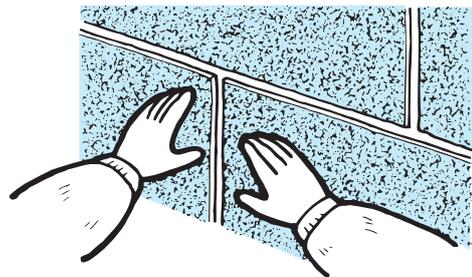
ユーネックスシートの接着状態の点検をかねてシートの四隅を両手で強く押圧し、圧着するとより密着します。
